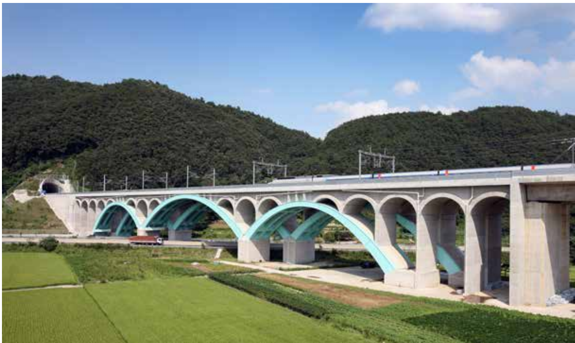
| 사진 137 | 경부고속철도 2단계 언양고가 (2010. 8. 26)
