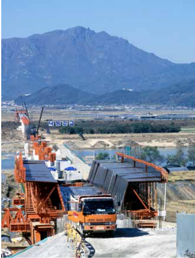
| 사진 124 | 경부고속철도 1단계 낙동강교 (1999. 11. 6, 경부고속)
