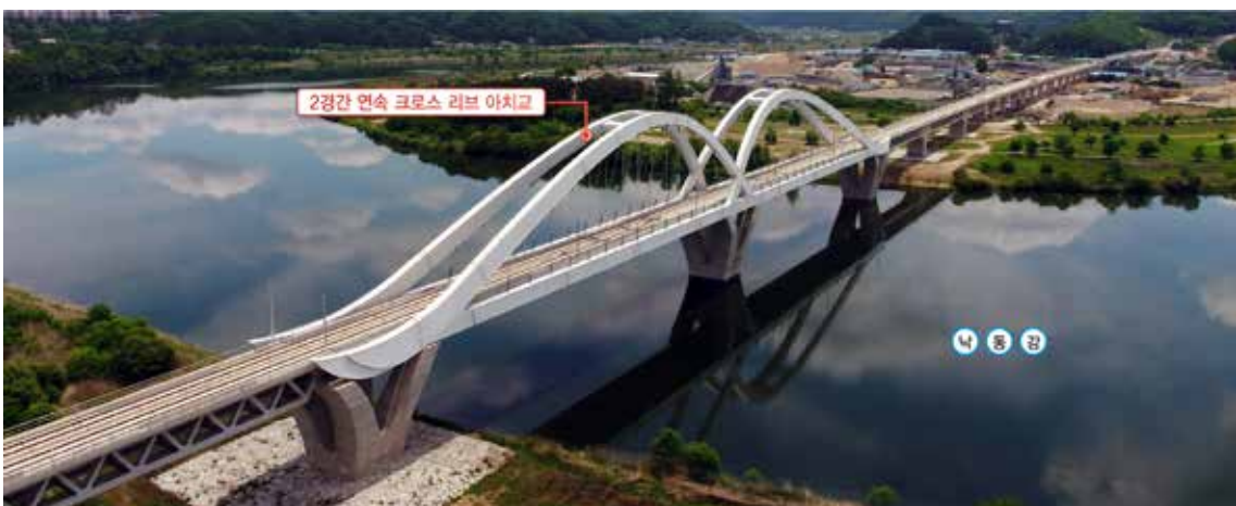
| 그림 2-47 | 도담~영천 복선전철 안동고가 전경
