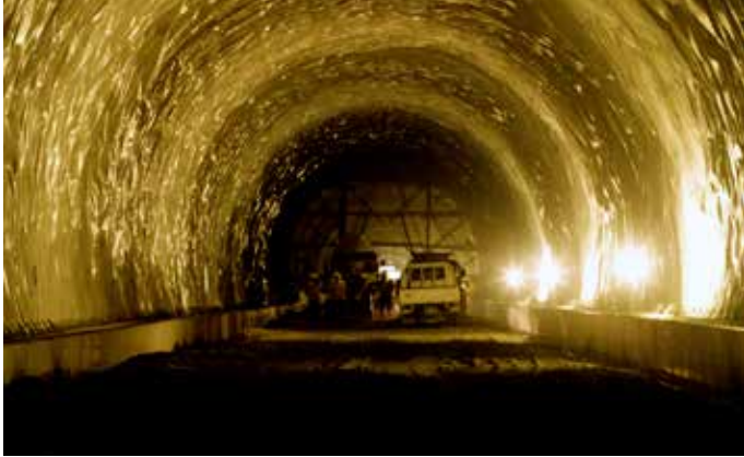
| 사진 145 | 경부고속철도 터널 상촌터널 (2000. 6. 12)
