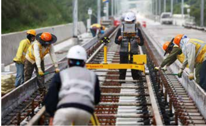
| 사진 132 | 경부고속철도 1단계 궤도 부설 (2009. 7. 29)
