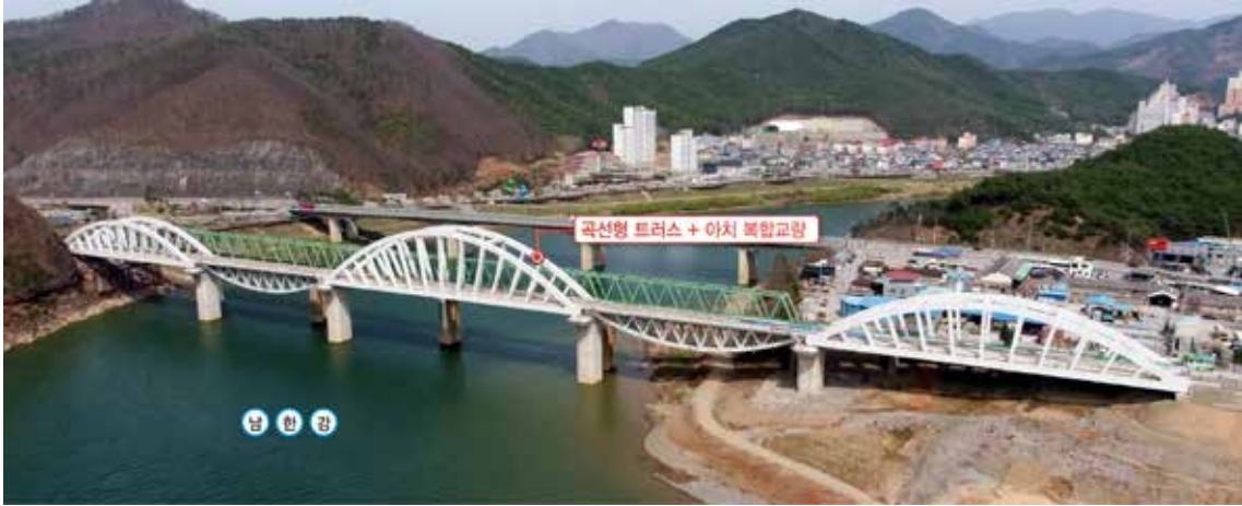
| 그림 2-46 | 도담~영천 복선전철 남한강교 전경
