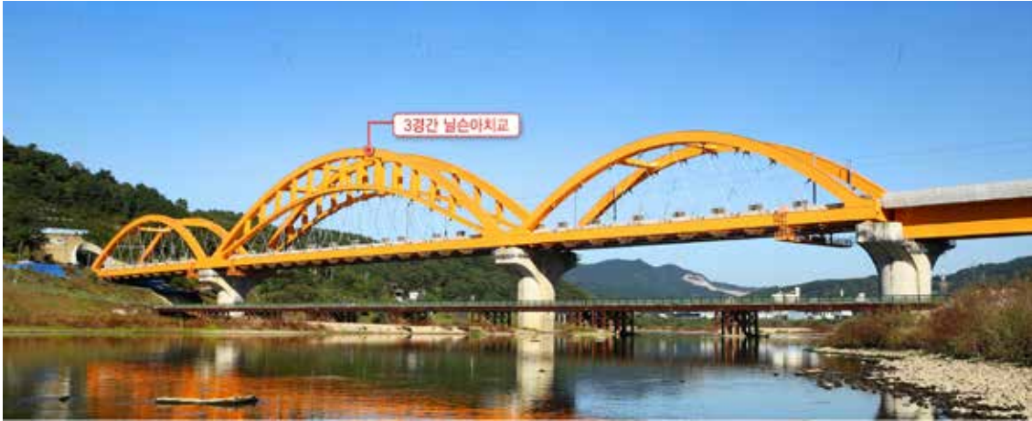
| 그림 2-17 | 호남고속철도 제1-2공구 금강교 전경
