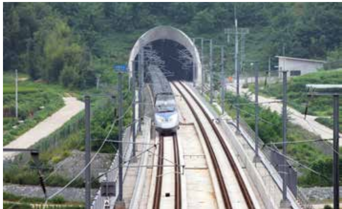
| 사진 151 | 경부고속철도 당리터널 (2010. 8. 25)
