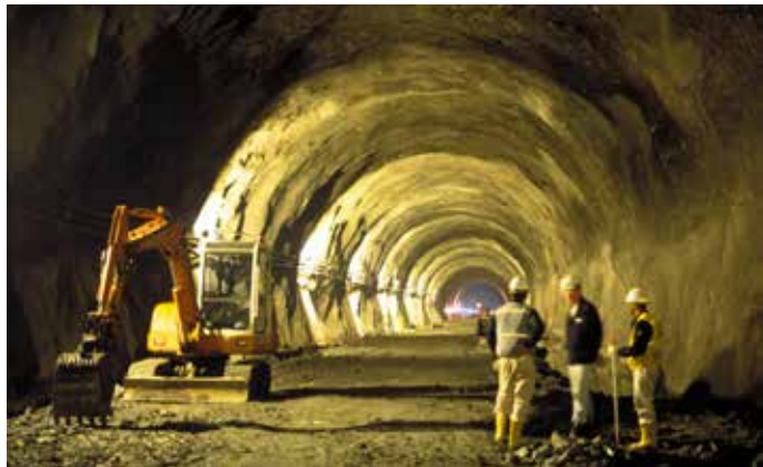
| 사진 143 | 경부고속철도 황학터널 (1999. 10. 20)
