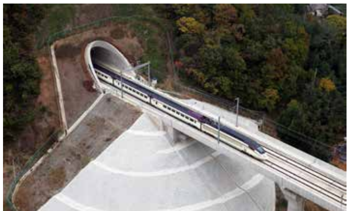
| 사진 156 | 호남고속철도 장산터널 (2014. 10. 29)
