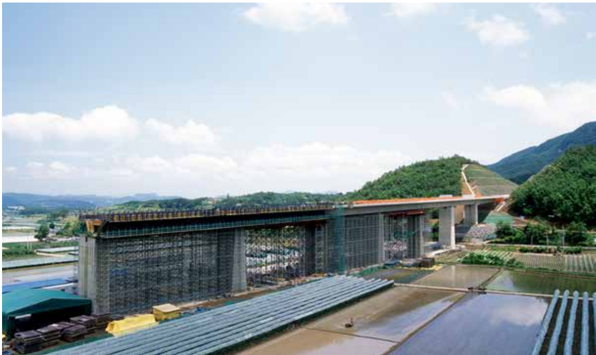
| 사진 140 | 경부고속철도 2단계 중리고가 (2005. 6. 2)
