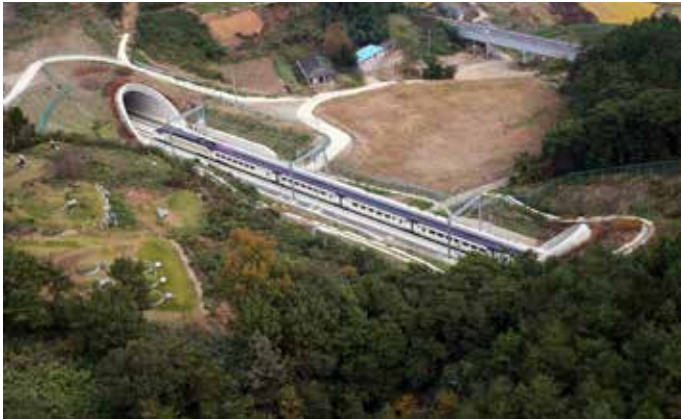
| 사진 154 | 호남고속철도 송현터널 (2014. 10. 29)
