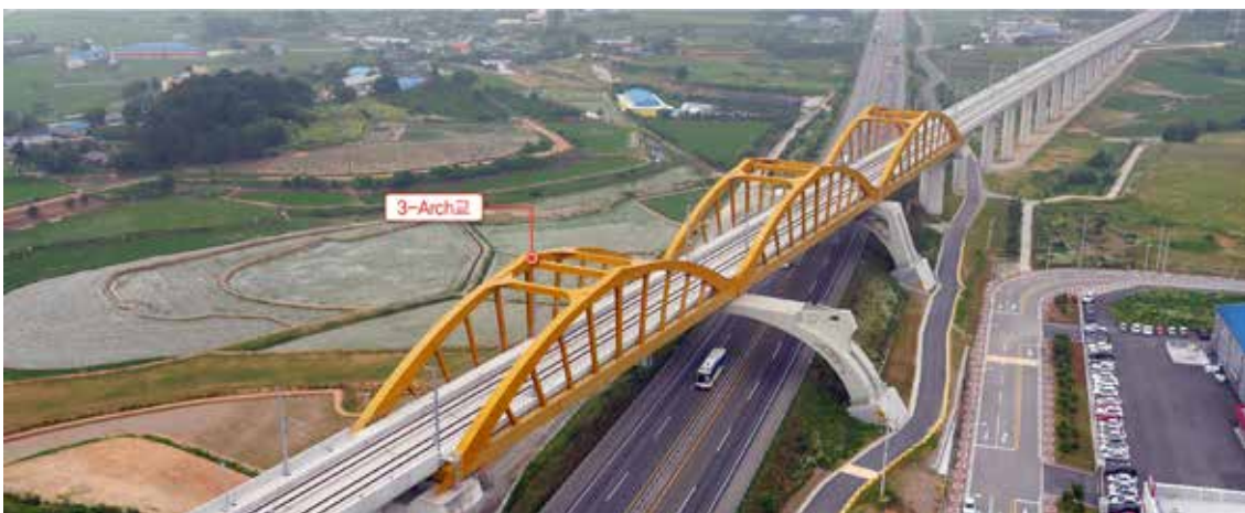
| 그림 2-18 | 호남고속철도 제2-3공구 정지고가 전경
