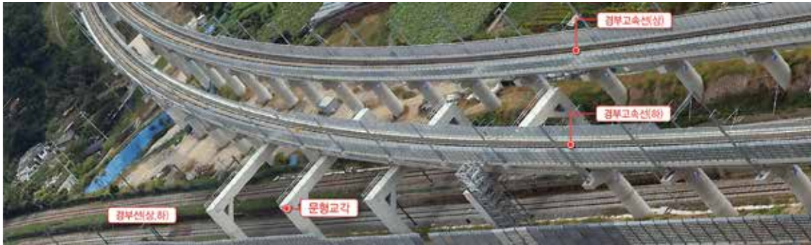
| 그림 2-23 | 경부고속철도 대전 도심 구간 판암1교 문형 교각 전경
