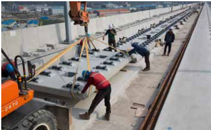
| 사진 133 | 경부고속철도 1단계 황룡2고가 (2014. 4. 10)
