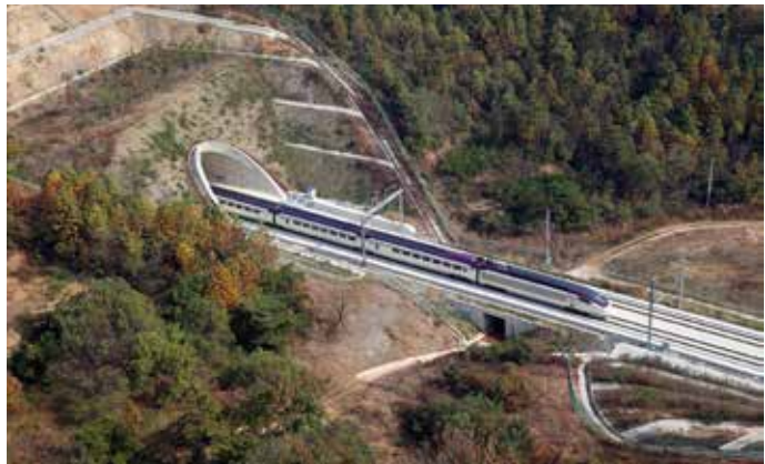
| 사진 155 | 호남고속철도 신영터널 (2014. 10. 29)
