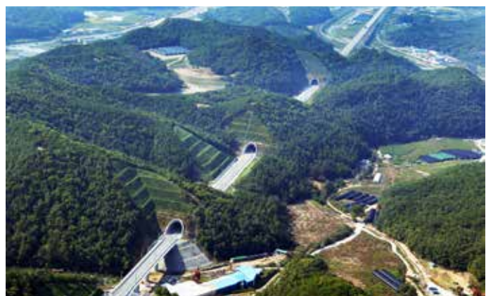
| 사진 148 | 경부고속철도 화신타널 (2002. 10. 8)
