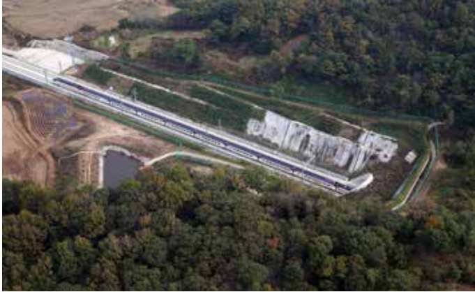
| 사진 153 | 호남고속철도 회룡터널 (2014. 10. 29)
