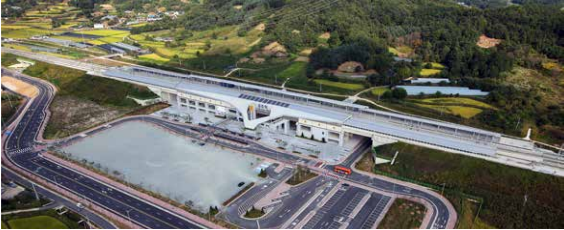
| 그림 2-20 | 호남고속철도 제2-1공구 공주역사 진입도로 전경
