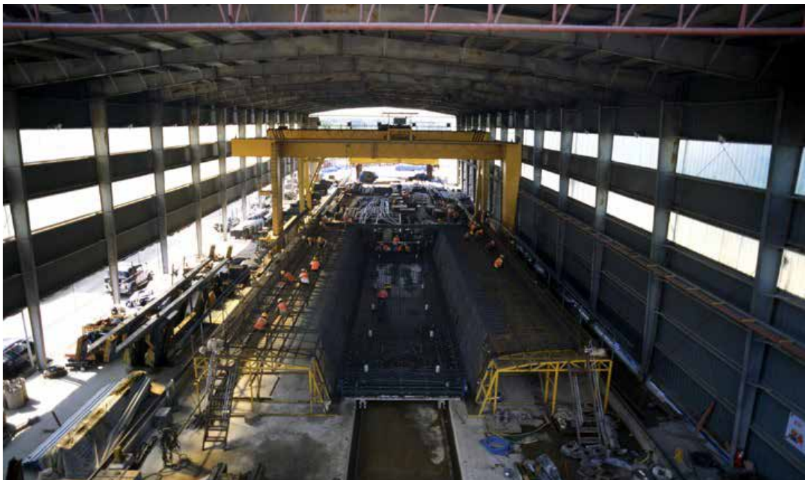
| 사진 123 | 경부고속철도 1단계 PC BOX공장 (2000. 8. 7)
