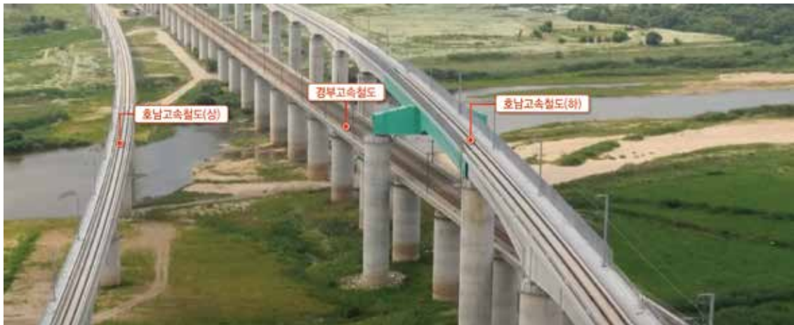
| 그림 2-16 | 호남고속철도 제1-1공구 오송고가 전경
