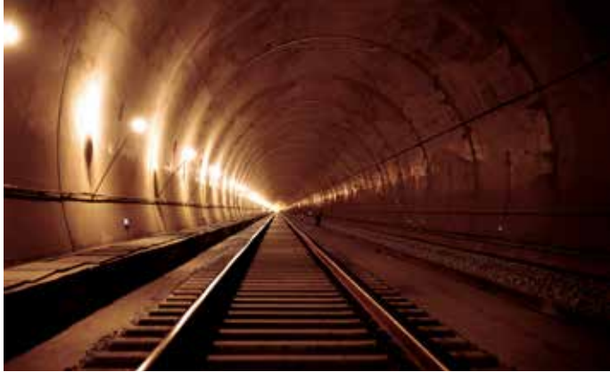
| 사진 141 | 경부고속철도 상봉터널 (1999. 4)
