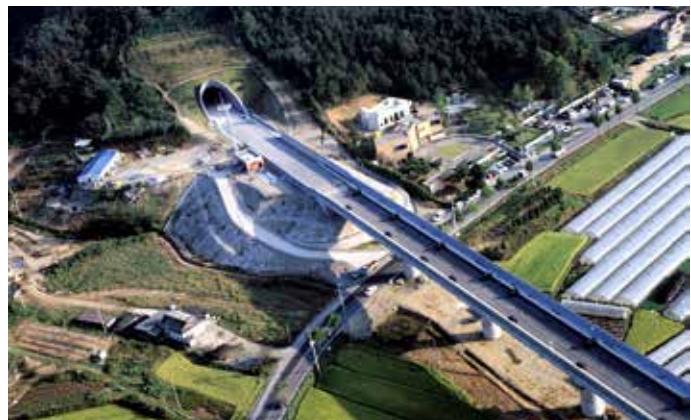
| 사진 147 | 경부고속철도 석적터널 (2002. 10. 8)
