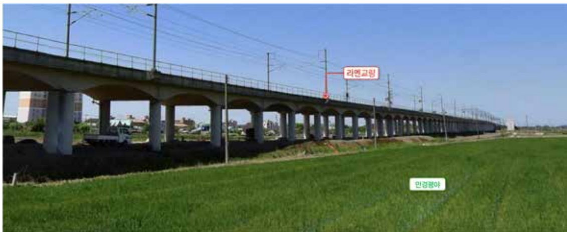
| 그림 2-11 | 전라선 복선전철 만경평야 통과, 이리천교 전경
