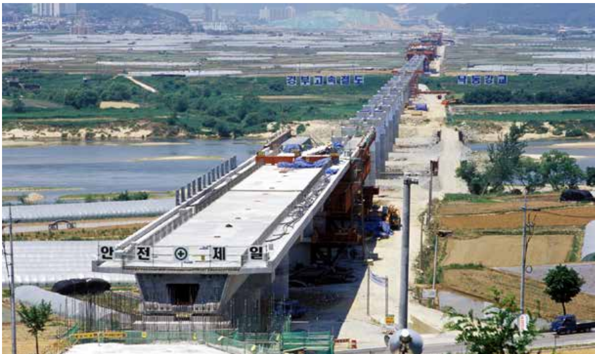
| 사진 125 | 경부고속철도 1단계 낙동강교 (2000. 6. 6, 경부고속)
