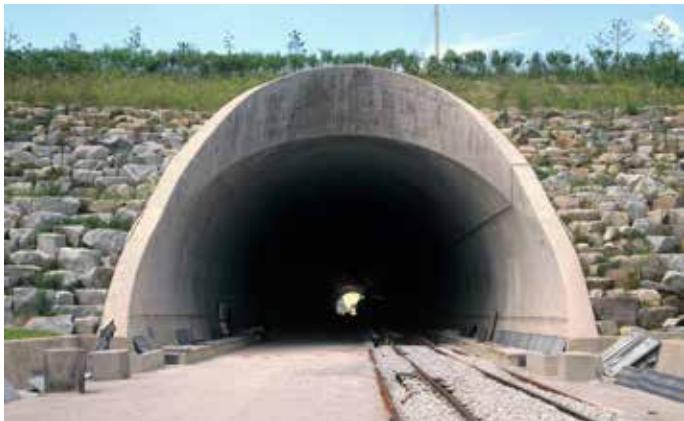
| 사진 142 | 경부고속철도 시목터널 (1999. 8. 10)
